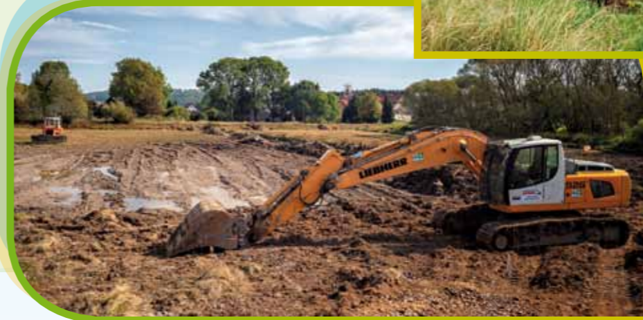
Die Maßnahme am Mittelteich: Die dichte Vegetationsdecke bindet Biomasse und Nährstoffe. Sie wird gemäht und abgeräumt. Der verbliebene Schlamm wird ausgebaggert, abtransportiert und dünn auf naheliegende Äcker ausgebracht, um die Fruchtbarkeit zu verbessern.
